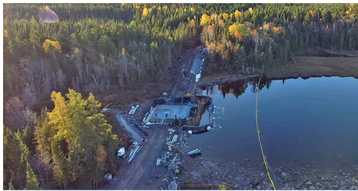
Travaux au lac Morigeau
