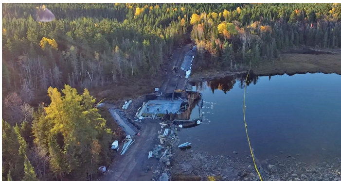
Travaux au lac Morigeau
